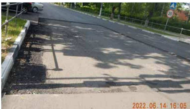
Ремонт нового асфальта. Первомайская, 9.
